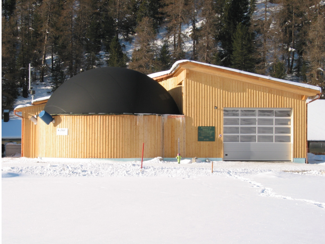
Abbildung 1: Neue Biogasanlage in Silvaplana (Genesys GmbH)
