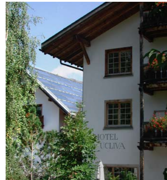
Das Genossenschaftshotel Ucliva in Waltensburg/Vuorz GR steht seit 1983 für Nachhaltigkeit im Bergtourismus. Das Hotel hat eine CO 2 -neutrale Energiebilanz, unter anderem dank 98 m 2 Sonnenkollektoren, die 35 Prozent des Energiebedarfs abdecken.
