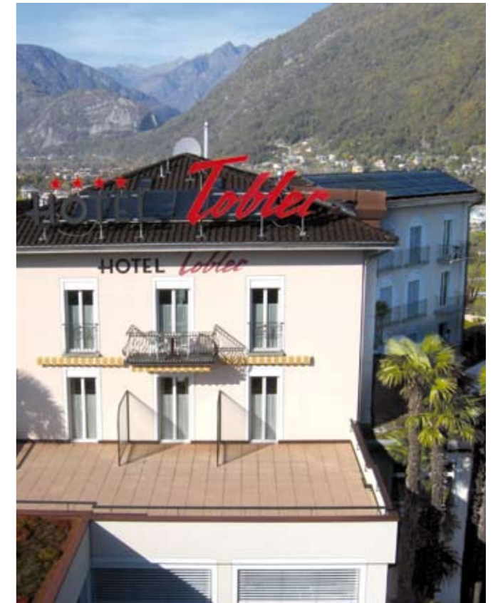
Das Viersterne-Hotel Tobler in Ascona heizt das Warmwasser für seine Gäste mit 110 m 2 Kollektorfläche auf.
