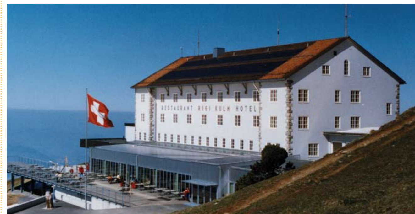
138 m 2 Solardachziegel auf dem Hotel Rigi-Kulm produzieren jährlich fast 12'000 Kilowattstunden sauberen Strom. Les 138 m 2 de tuiles solaires sur le toit de l'hôtel Rigi-Kulm produisent chaque année près de 12'000 Kilowattheures d'électricité propre.
