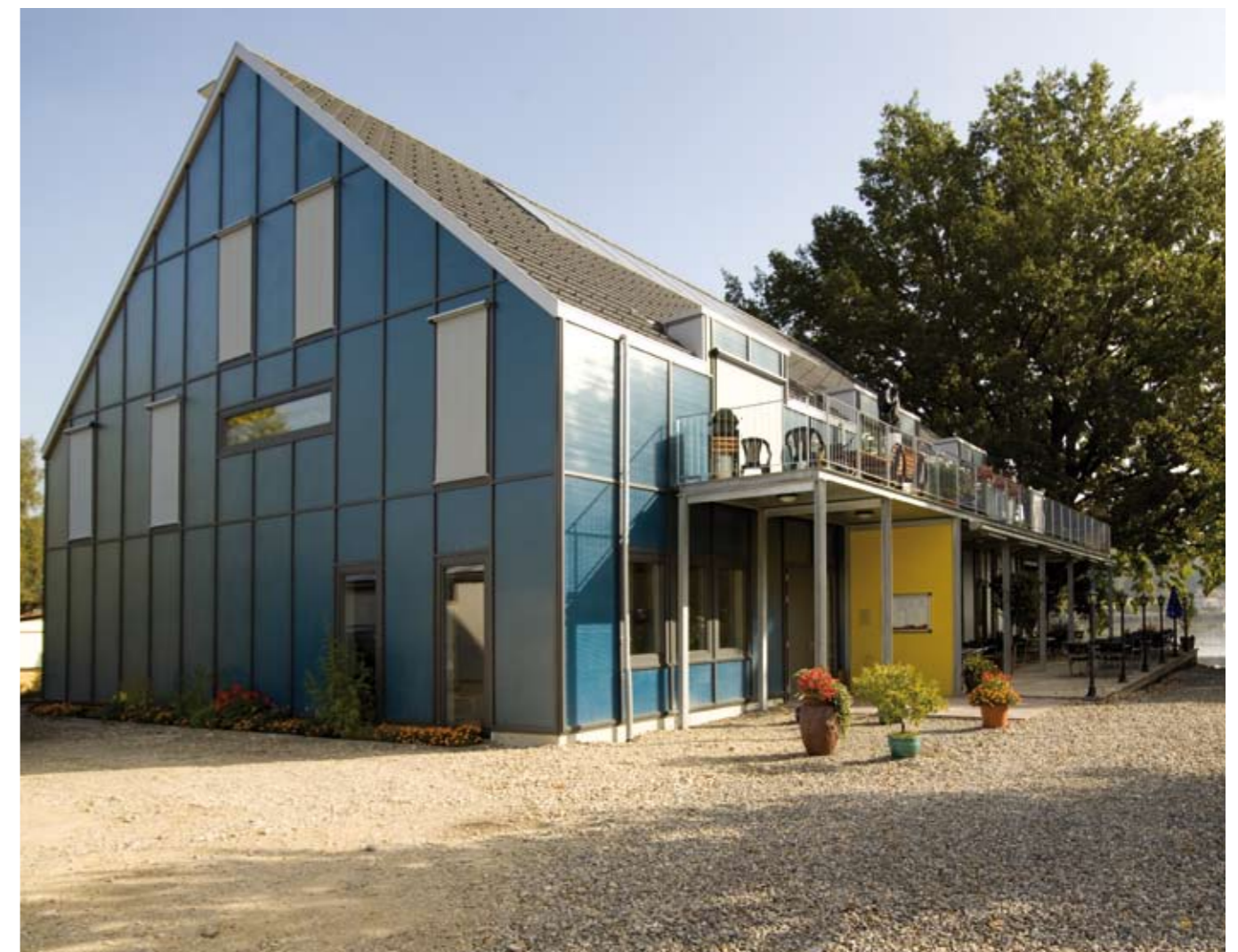
Restaurant Seerose am Moossee nach Minergie-P-Standard. Wärmegewinnung mit Solarfassade Lucido®. © Robert Bachofner. Restaurant Seerose au bord du lac Moossee selon norme Minergie-P. Production de chaleur avec façade solaire Lucido®. © Robert Bachofner.
