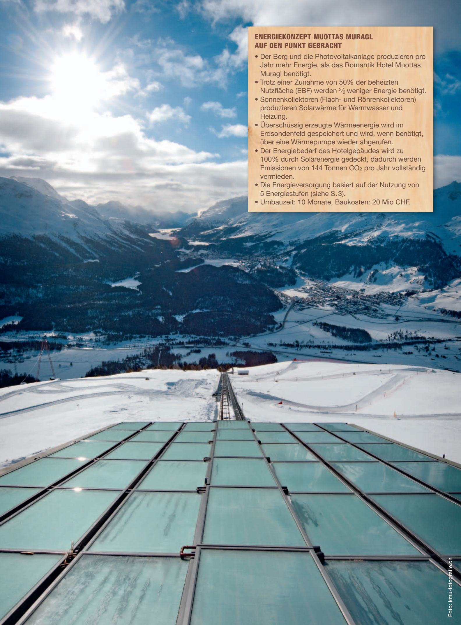
Die 84 m 2 Flachkollektoren auf dem Vordach der Bergstation und die 56 m 2 perfekt fensterintegrierten Röhrenkollektoren erzeugen insgesamt 70 800 kWh/a Wärmeenergie.
